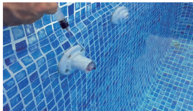
Tinta para detección de fugas en piscinas
