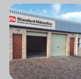
Sudáfrica (Port Elizabeth) Superficie 220 m2 Facilities / Installations
