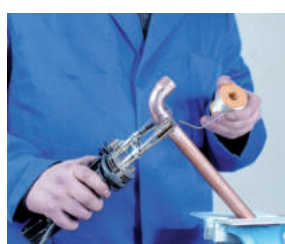
5. Aplicación de la soldadura 5. Aplicação da soldadura
