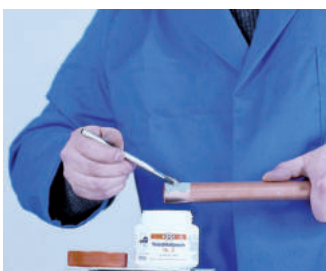
4. Aplicación del decapante 4. Aplicação do decapante
