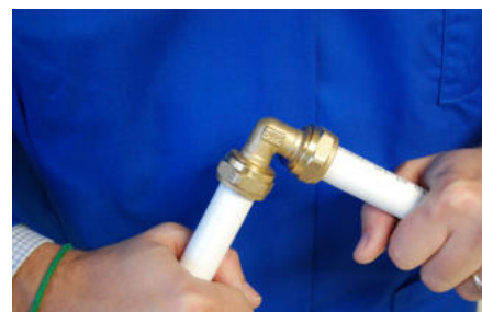
5. Montaje finalizado 5. Montagem terminada
