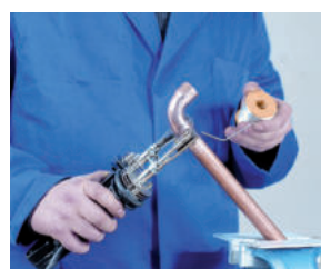
5. Aplicación de la soldadura 5. Aplicação da soldadura
