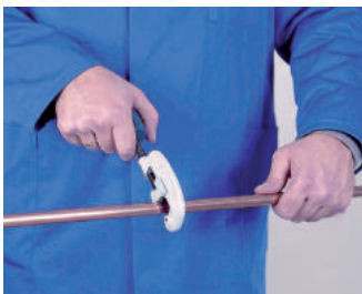
1. Corte de tubo 1. Cortar o tubo
