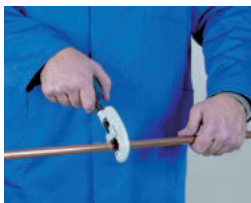
1. Corte de tubo 1. Cortar o tubo
