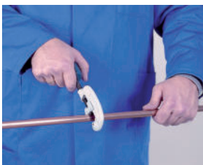
1. Corte de tubo 1. Cortar o tubo
