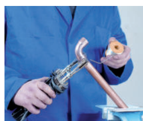
5. Aplicación de la soldadura 5. Aplicação da soldadura
