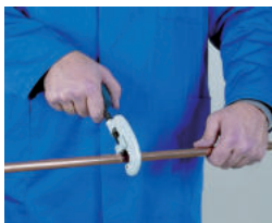
1. Corte de tubo 1. Cortar o tubo
