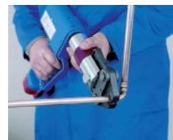
6. Prensado 6. Prensado
