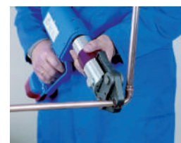
6. Prensado 6. Prensado
