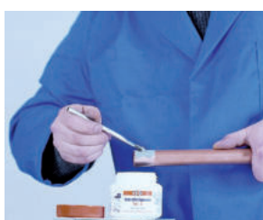
4. Aplicación del decapante 4. Aplicação do decapante
