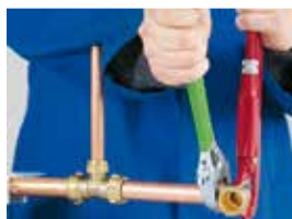
4. Ajustar la unión mediante una llave inglesa 4. Ajustar a união com uma chave inglesa
