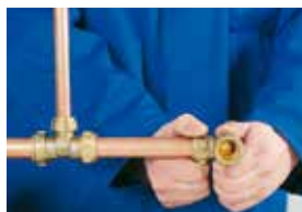
3. Inserción del tubo en el accesorio 3. Encaixe do tubo no acessório
