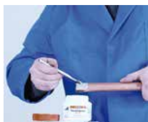
4. Aplicación del decapante 4. Aplicação do decapante
