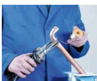
5. Aplicación de la soldadura fuerte 5. Aplicação da soldadura forte
