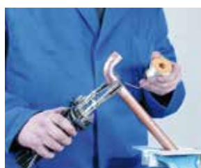
5. Aplicación de la soldadura 5. Aplicação da soldadura
