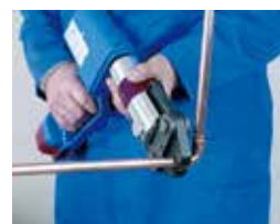
6. Prensado 6. Prensado
