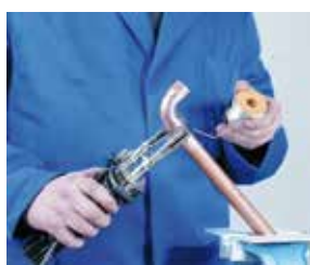
5. Aplicación de la soldadura 5. Aplicação da soldadura
