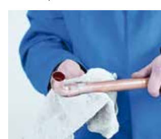
6. Limpieza final 6. Limpeza final
