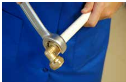
4. Ajustar la unión usando una llave inglesa 4. Ajustar a união com uma chave inglesa
