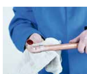
6. Limpieza final 6. Limpeza final
