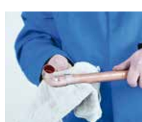
6. Limpieza final 6. Limpeza final
