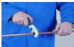
1.- Corte de tubo 1.- Cortar o tubo
