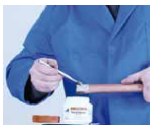
4. Aplicación del decapante 4. Aplicação do decapante
