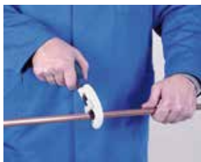
1. Corte de tubo 1. Cortar o tubo
