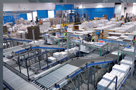
NUEVO CENTRO LOGÍSTICO NEW LOGISTIC CENTER
