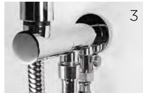
Una vez cerrada la llave, el paso de agua hacia el WC queda interrumpido.
